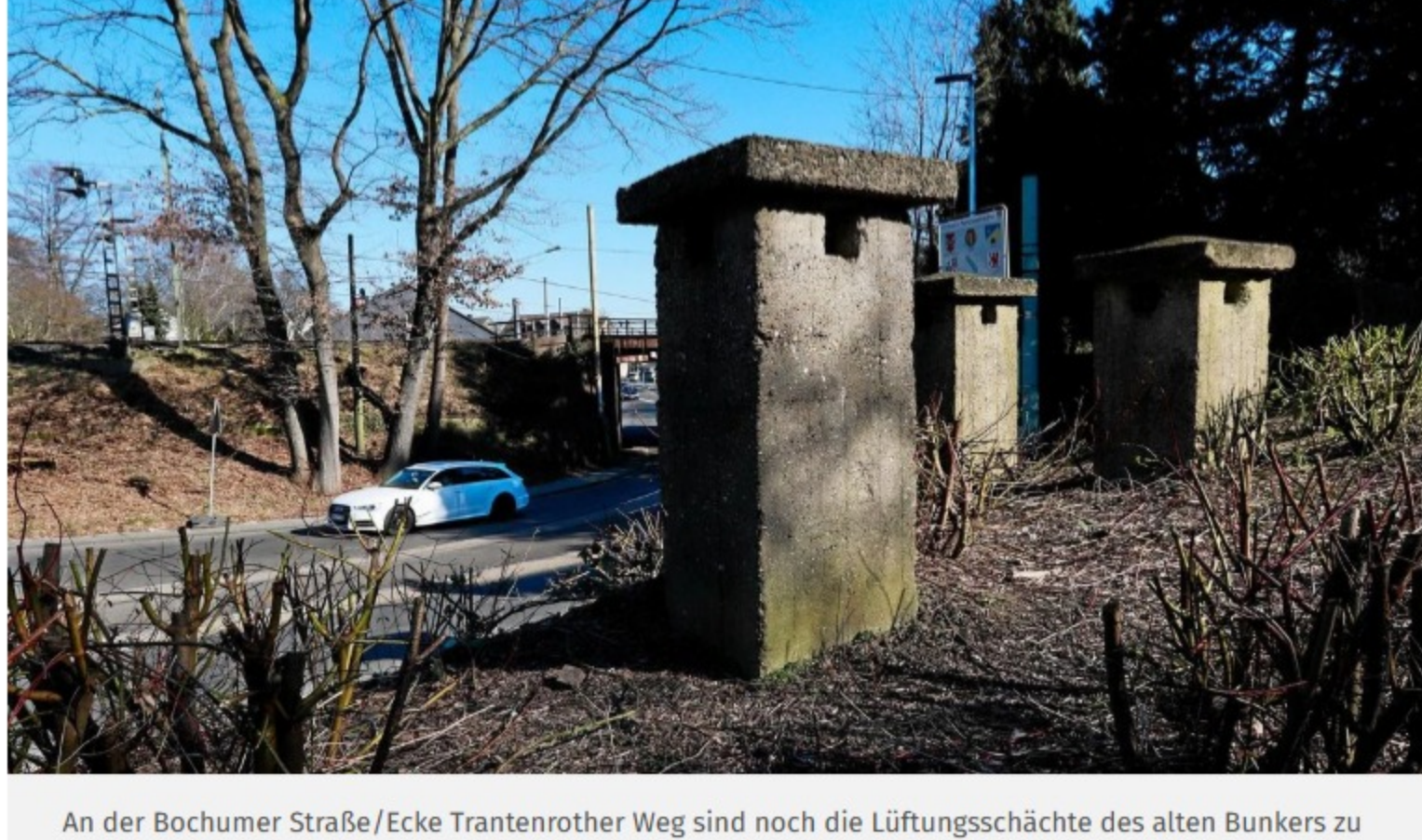
An der Bochumer Straße/Ecke Trantenrother Weg sind noch die Lüftungsschächte des alten Bunkers zu sehen.
