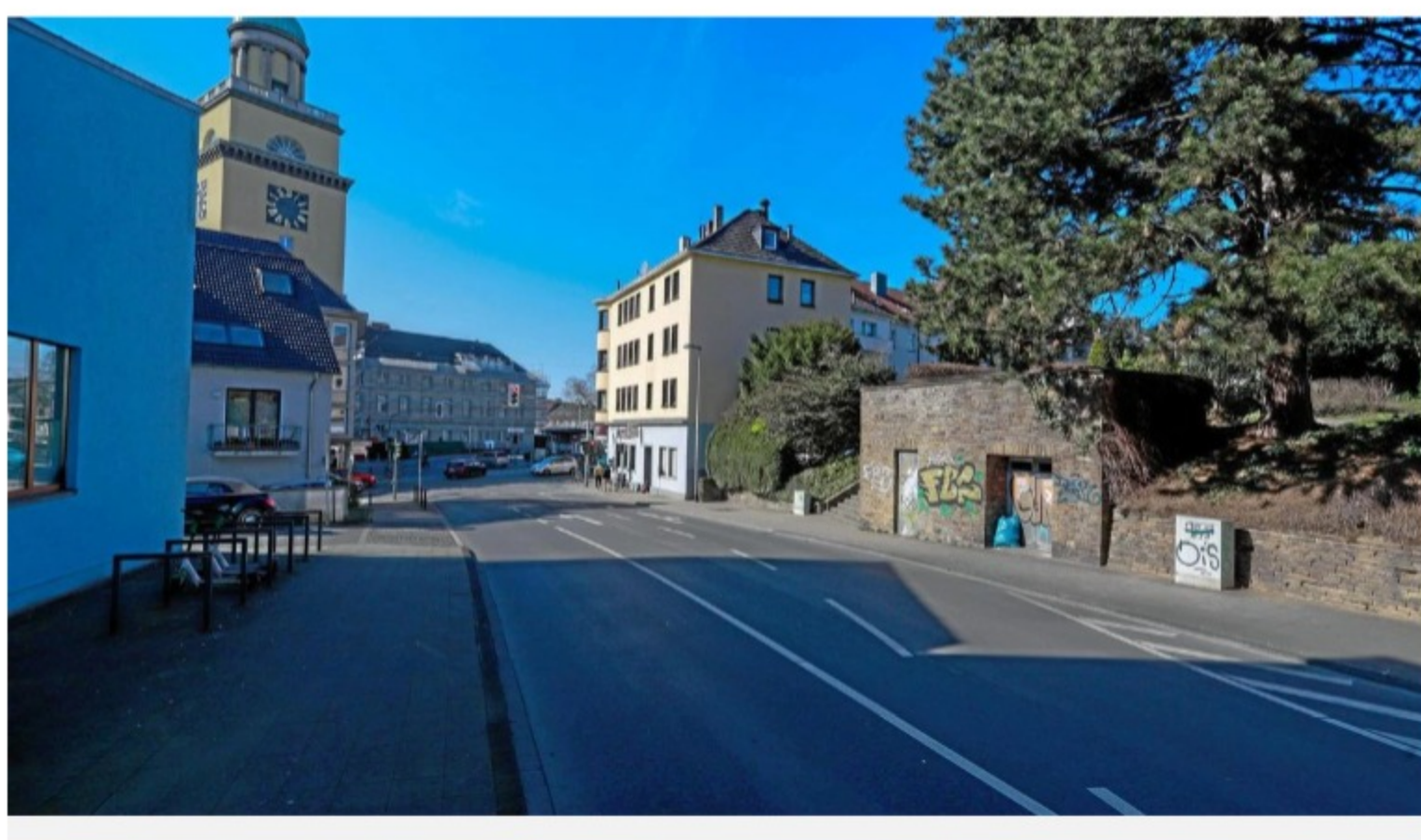
Von der Bonhoefferstraße aus sieht man vorne rechts den Zugang zum Bunker unter dem Lutherpark in Witten.
