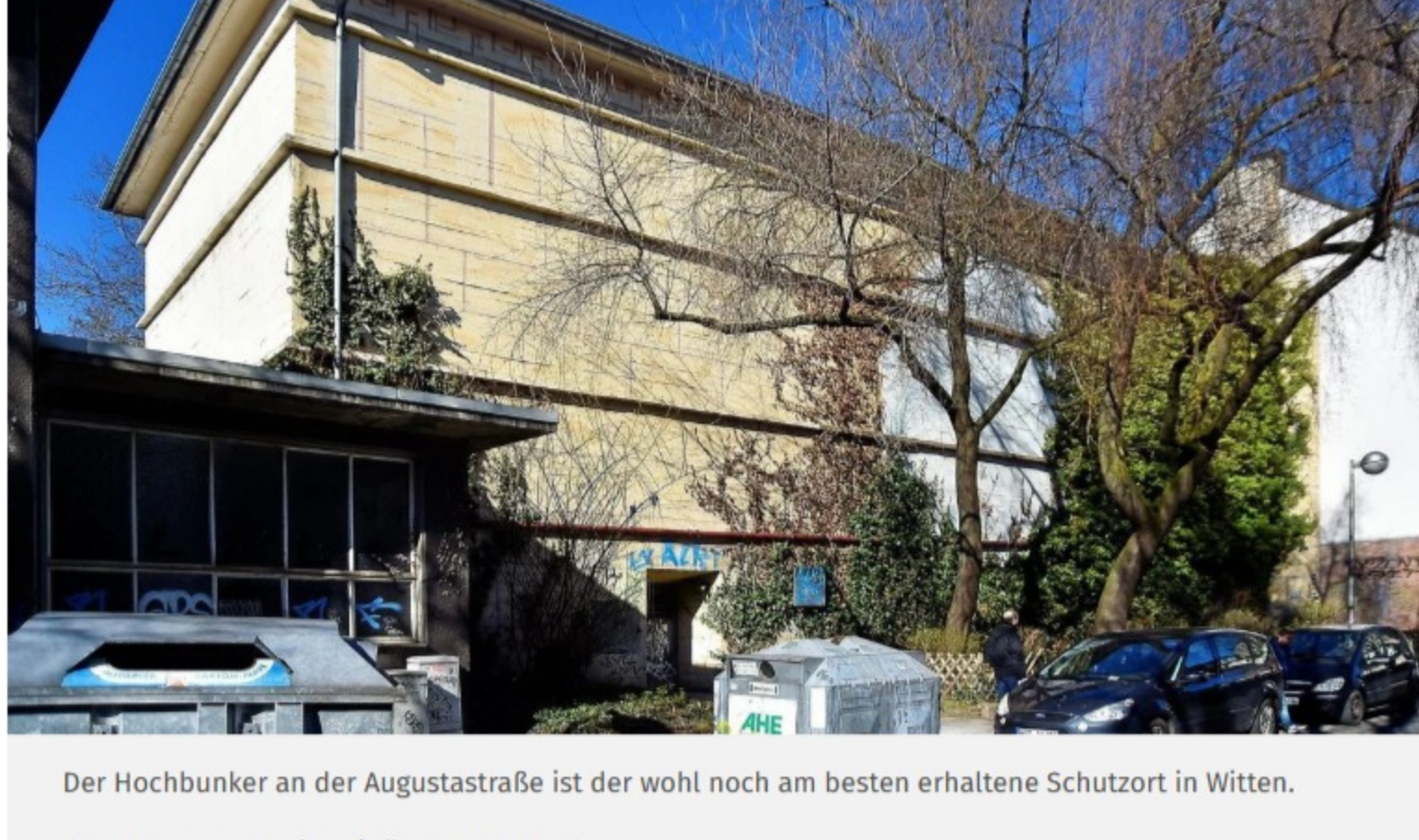
Der Hochbunker an der Augustastraße ist der wohl noch am besten erhaltene Schutzort in Witten.
