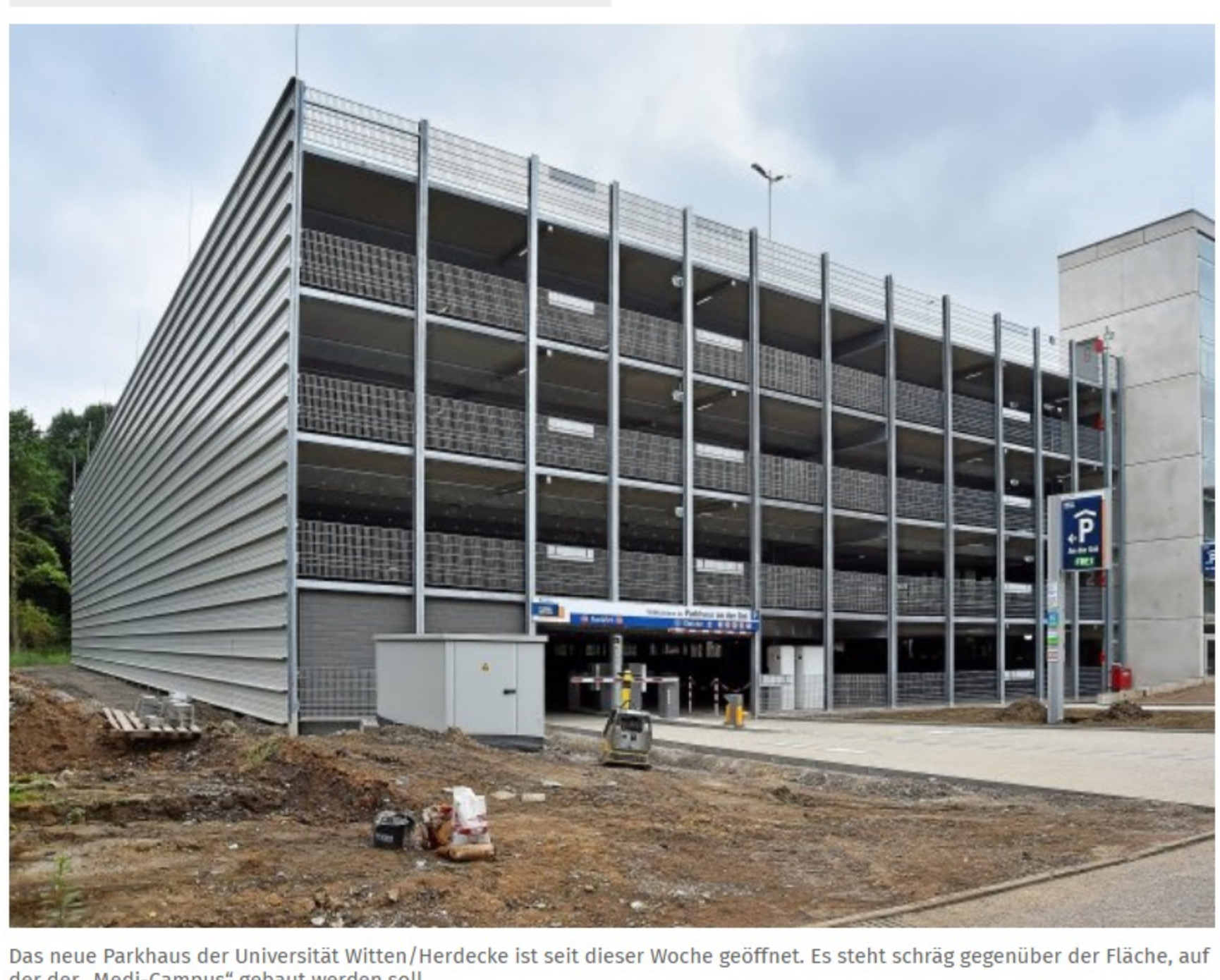
Das neue Parkhaus der Universität Witten/Herdecke ist seit dieser Woche geöffnet. Es steht schräg gegenüber der Fläche, auf der der „Medi-Campus“ gebaut werden soll. Foto: Jürgen Theobald / FUNKE Foto Services
