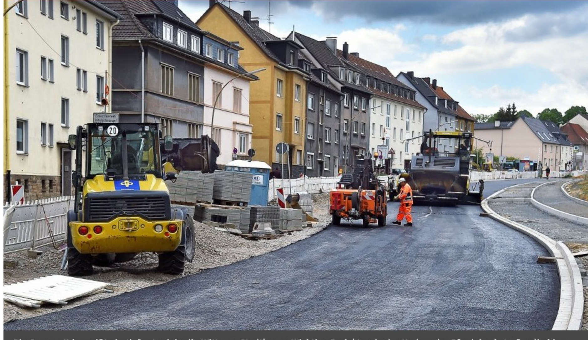
Die Corona-Krise reißt ein tiefes Loch in die Wittener Stadtkasse. Wichtige Projekte wie der Umbau der Pferdebachstraße, die hier schon asphaltiert wird, laufen aber weiter. Foto: Jürgen Theobald / FUNKE Foto Services
